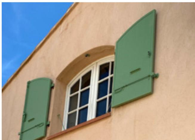
Volet battant isolant, cadre large, modèle ISO avec dispositif de retenue française avec pièce murale
