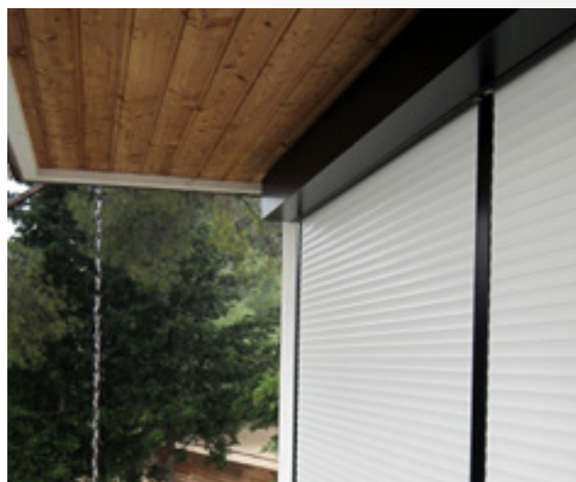
Pose de face enroulement extérieur à fleur plafond, combinaison de coffre carré et coulisses doubles
