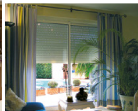
Volet roulant traditionnel pose en tableau dans un coffre bois intérieur
