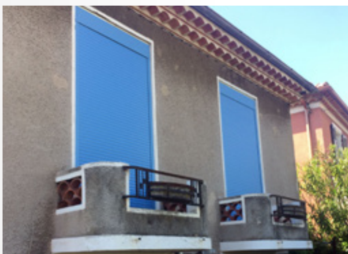
Pose tableau enroulement intérieur
