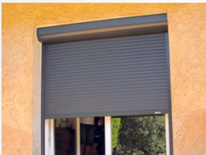
Pose tableau enroulement extérieur
